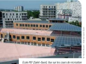
ole PEF (Saint-Uuen). Vue sur les cours de recreation en toiture et les panneaux photovoltaï ques. Orientation sud pour toutes les salles de classes afin d'optimiser l'énergie passive.
