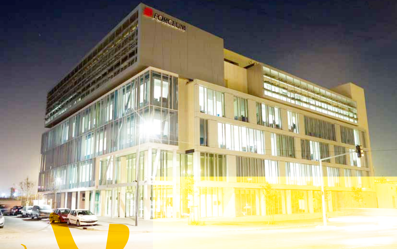
Un immeuble à énergie positive à Saint-Denis Building with positive energy in Saint-Denis
