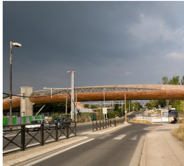
Passerelle au-dessus des voies de la grande ceinture - Villetaneuse
