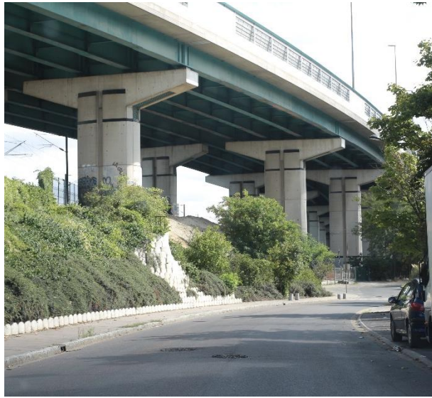
Viaduc A86, Aubervilliers
