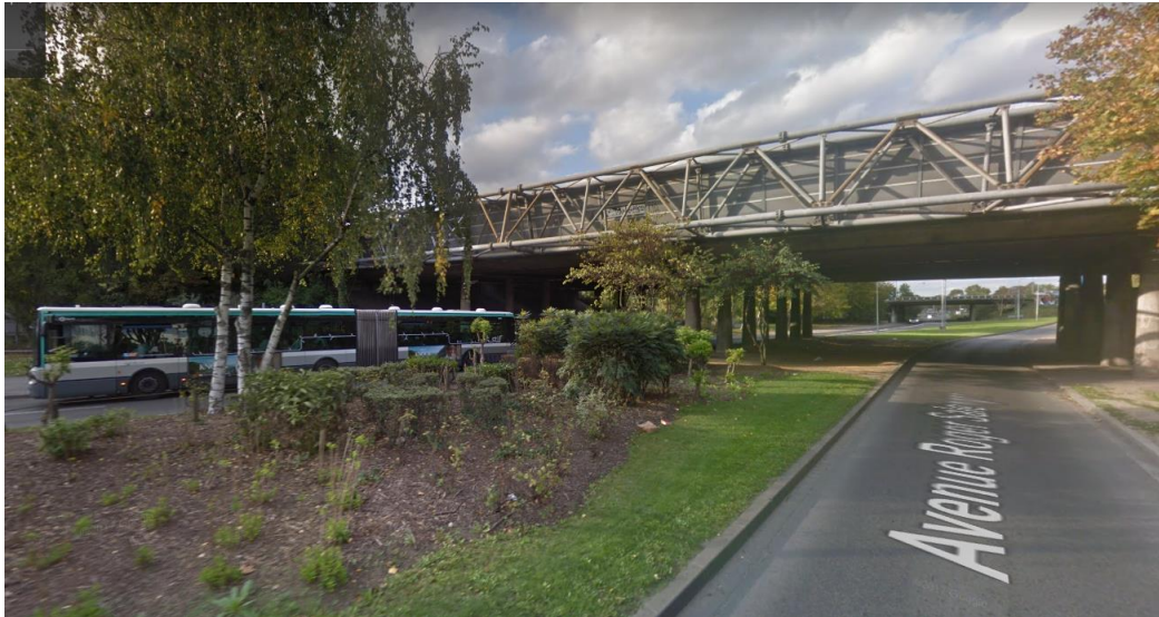
N301 – passage sous l'autoroute A1 à La Courneuve en direction du parc G.Valbon
